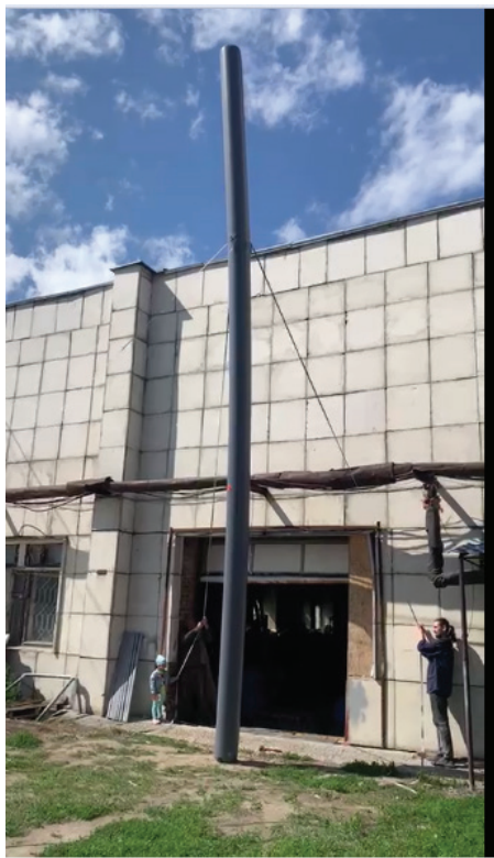
Рисунок 1. Надувная опора антенны
